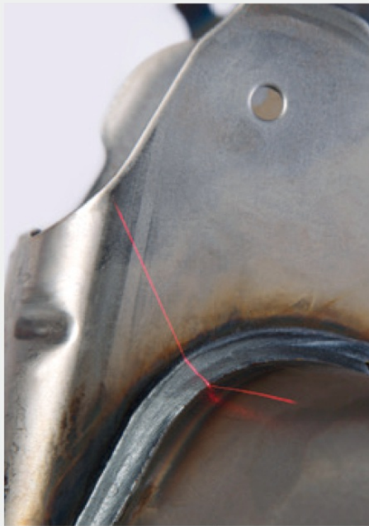
스틸 용접 비드의 검사
